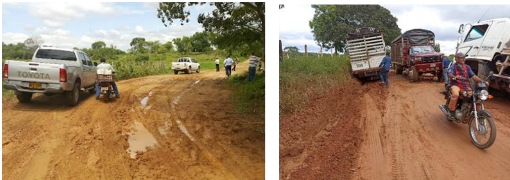
Figura 9. Estado de la vía en época de invierno
