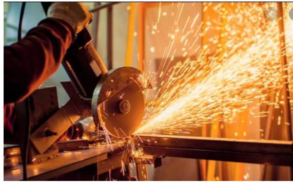
Ilustración 31. Operación de corte de tubería
