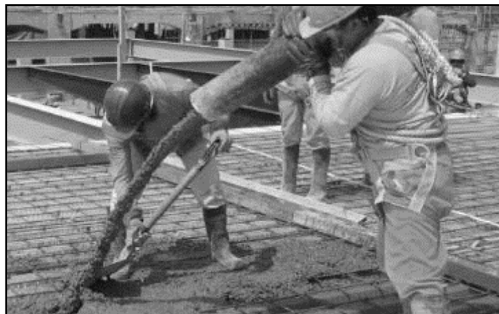
Figura 16. Vaciado de Concreto. Fuente: https://www.acero-deck.com/instalacion
