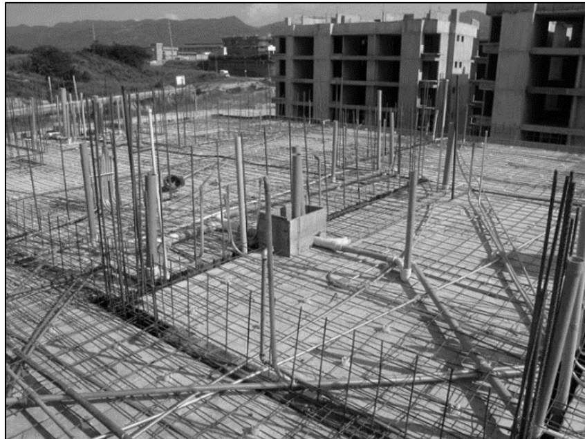
Figura 15. Preparación de las redes hidrosanitarias y eléctricas sobre la losa previo al vaciado de concreto. Fuente:
