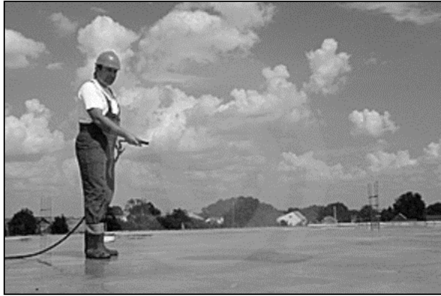
Figura 17. Curado del Concreto. Fuente: http://www.tecnopreco.com/2016/11/07/la-importancia-del-curado-en-las-losas-de-hormigon/
