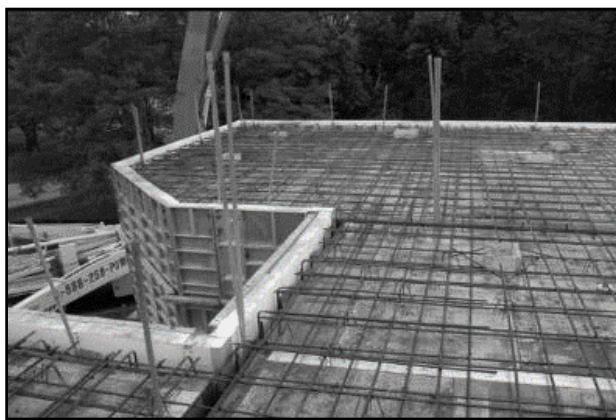
Figura 14. Instalación del acero de refuerzo. Fuente: https://www.360enconcreto.com/blog/detalle/construccion-de-placas-de-entrepiso
