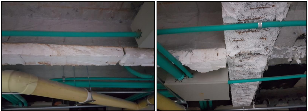
Figura 22. Evidencia del material (Poliestireno Expandido) utilizado como encofrado en la superficie inferior de las Vigas. Fuente: Propia.
