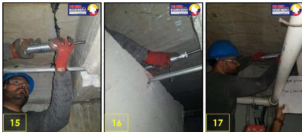
Figura 34. Ensayo de esclerometría a los elementos estructurales en estudio del edificio San Silvestre II. Fuente: Propia.
