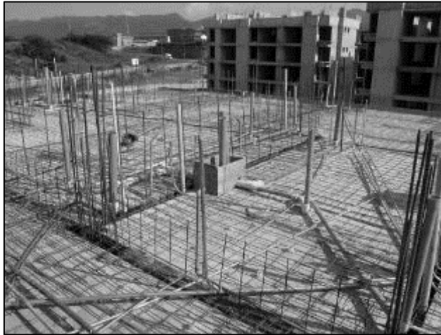
Figura 9. Preparación de Losa o Placa Entrepiso.
