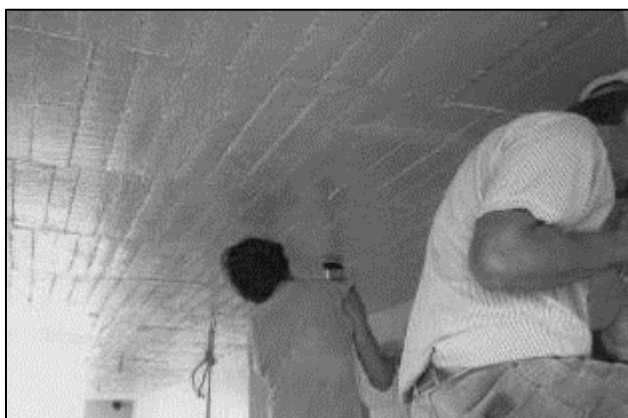
Figura 53. Pintura de protección bajo placa de concreto. Fuente: Asocreto
