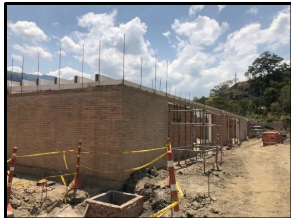
Fotografía 20. Mampostería Edificio Operativo. Fuente. Autor.
