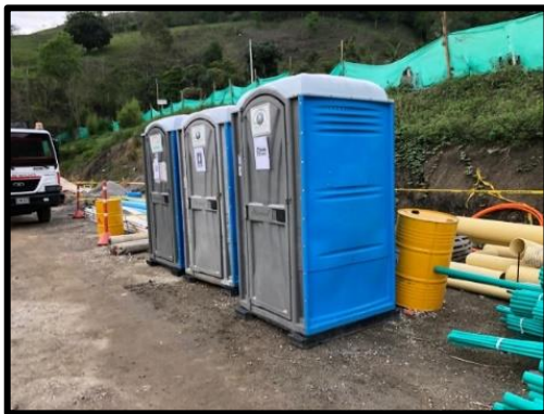
Fotografía 15. Instalación de Baños Portátiles. Fuente: Autor.
