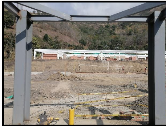
Fotografía 2. Extendida de Base Terraza tres. Fuente: Autor.
