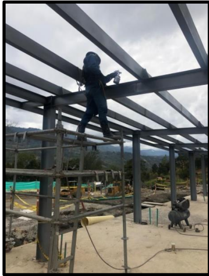
Fotografía 17. Instalación y Pintura Edificio Operativo. Fuente. Autor.
