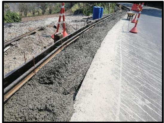
Fotografía 14. Vaciado de concreto para cunetas. Fuente: Autor.
