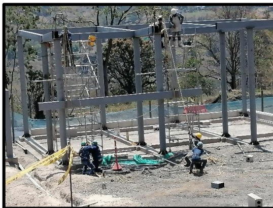
Fotografía 4. Instalación Estructura Metálica Parqueadero. Fuente: Autor.
