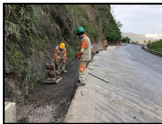
Fotografía 12. Compactación de Subbase para Cunetas.
