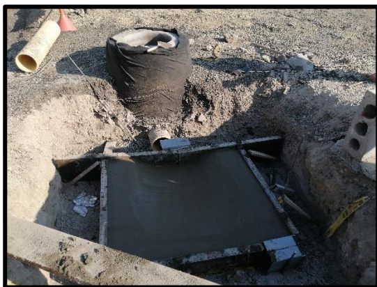
Fotografía 5. Pozo Sanitario Terraza tres. Fuente: Autor.
