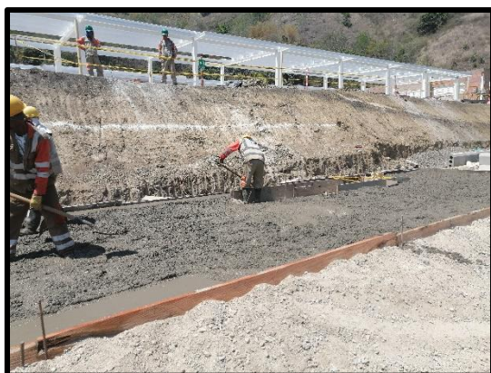
Fotografía 3. Fundida de Losa Subestación Eléctrica. Fuente: Autor.
