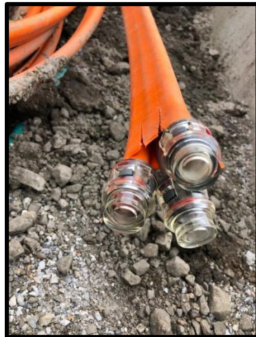
Fotografía 19. Instalación Duraline Fuente. Autor.
