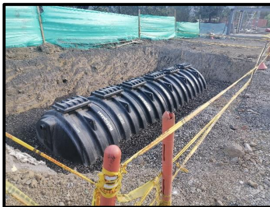
Fotografía 8. Instalación Pozo Séptico.
