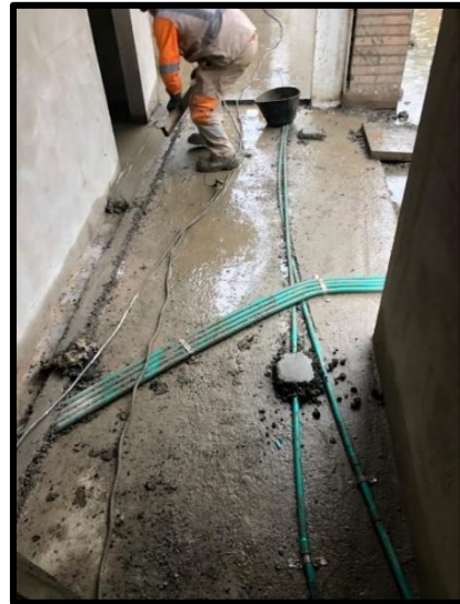
Fotografía 18. Instalación Tubería Conduit Eléctrica y Comunicaciones. Fuente. Autor.
