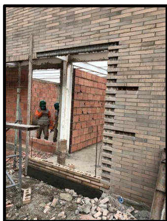
Fotografía 11. Mampostería Edificio Comercial.
