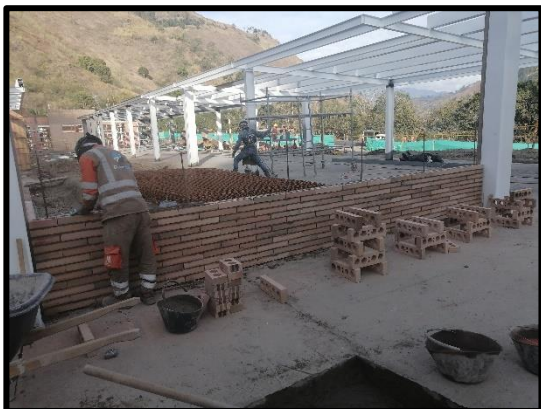
Fotografía 1. Mampostería Edificio Operativo. Fuente: Autor.
