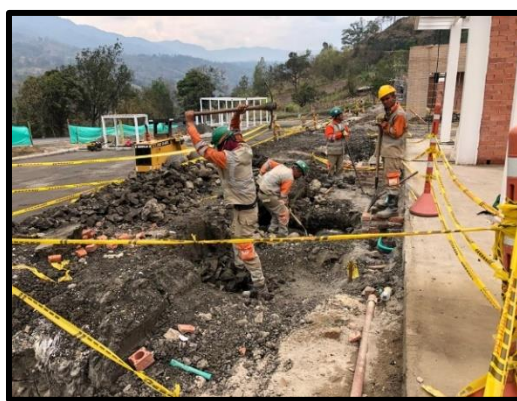
Fotografía 10. Excavación para Pozos.
