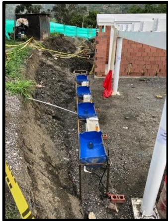
Fotografía 13. Instalación Lavamanos. Fuente: Autor.
