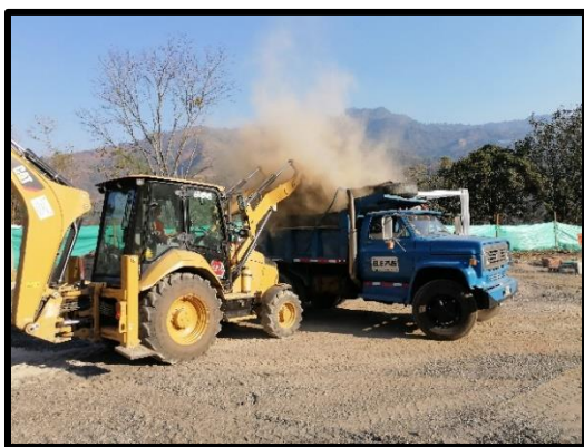
Fotografía 9. Salida de Escombros Terraza tres.
