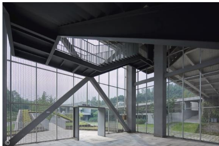
Figura 47. Relación interior – exterior del Centro Comunitario Chongqing.
