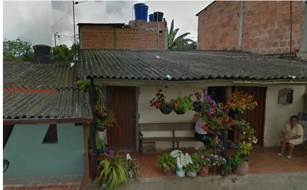
Figura 61. Viviendas centro poblado
