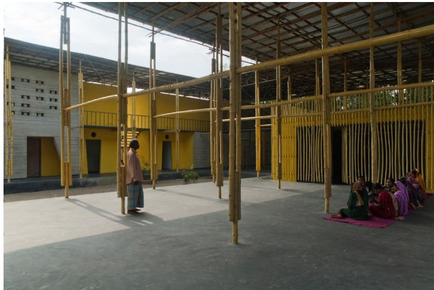
Figura 35. Zona de trabajo 1 piso Centro Comunitario Pani.
