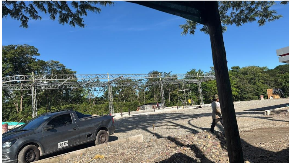
Figura 2 Obra y el almacén al fondo.
