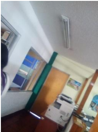
Figura 10: Verificación del estado de las luminarias y equipos energéticos.
