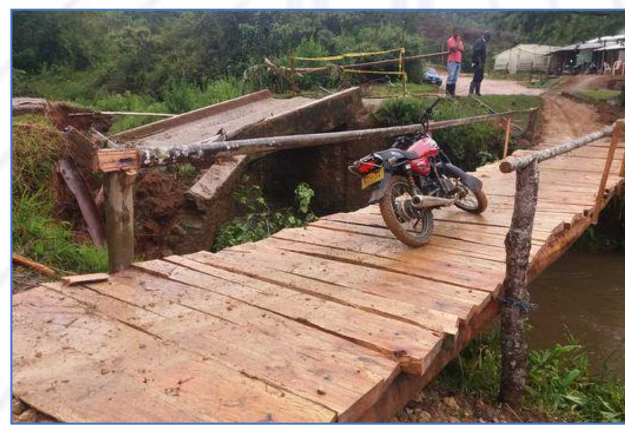
Puente Las Botas Del Tambo EL TAMBO-CAUCA
