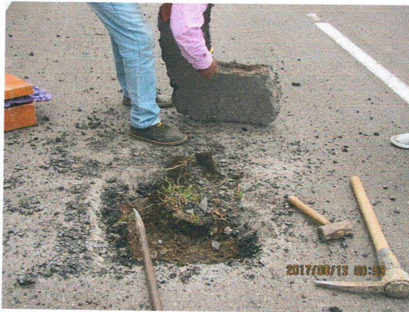
Apique # 3, Tramo final A 206 metros del cruce con la vía Túquerres - Pedregal.
