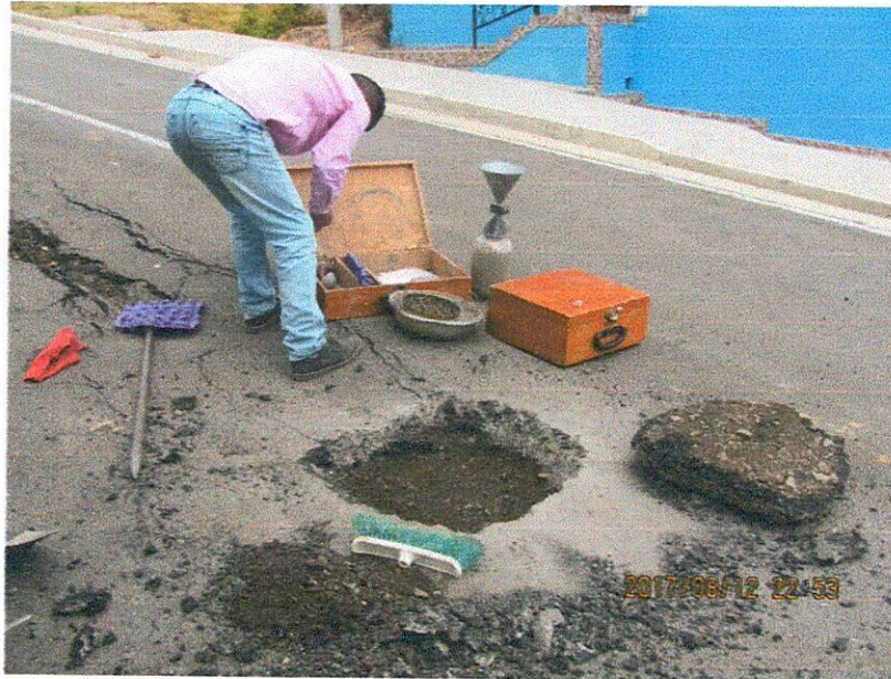
Apique # 1 frente a casa de Alicia Lucano. Tramo inicial de la obra.
