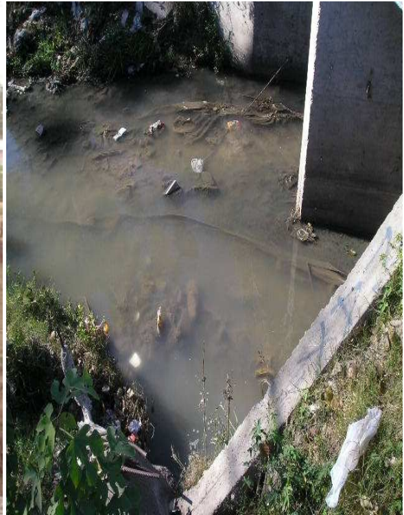
Fotografía No. 3 - punto PB2 (Contaminación Hídrica por residuos líquidos y sólidos)
