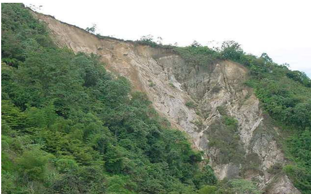
Fotografía 16 – PA1 - Remoción en masa por pérdida de cobertura vegetal de soporte al talud.
