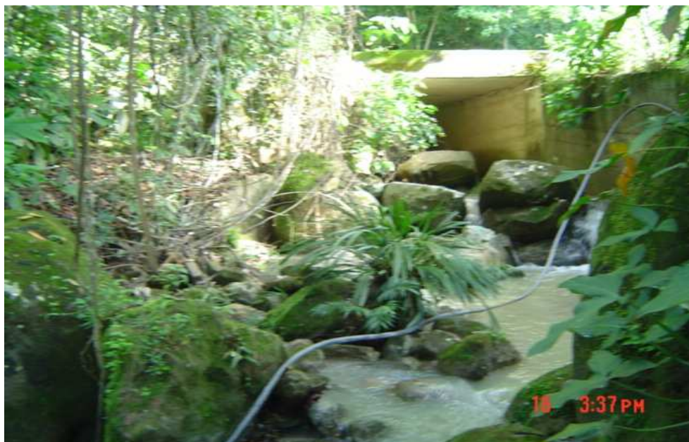
Fotografía No. 5 - Quebrada la Palmara – detalle de la turbiedad y bajo caudal del agua en esta zona (media) debido a la disposición de aguas servidas y a la intervención humana con construcciones civiles de concreto como son puentes y canales de tipo box culvert, así como mangueras de conducción, las cuales afectan el flujo, la corriente y las interacciones biofísicas del agua con los organismos que viven en este tipo de ecosistemas.
