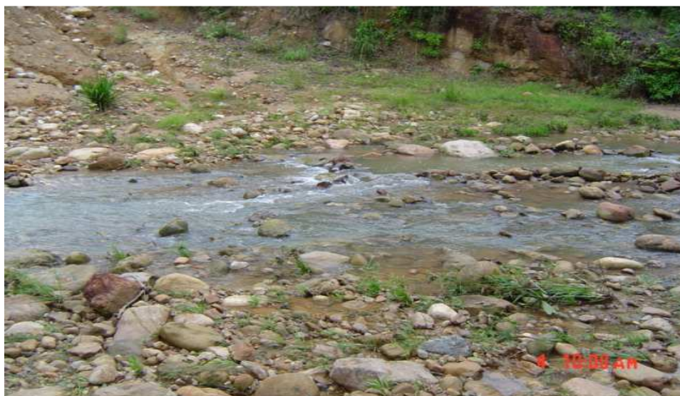
Fotografía No. 6 - Bajo caudal y procesos erosivos en la parte media la quebrada la Palmara.
