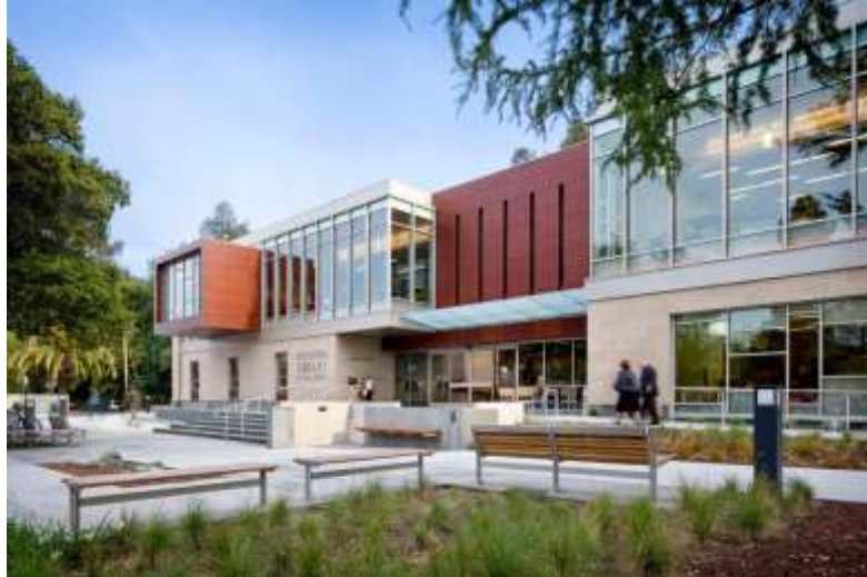
Figura 26. Fachada Biblioteca los gatos
