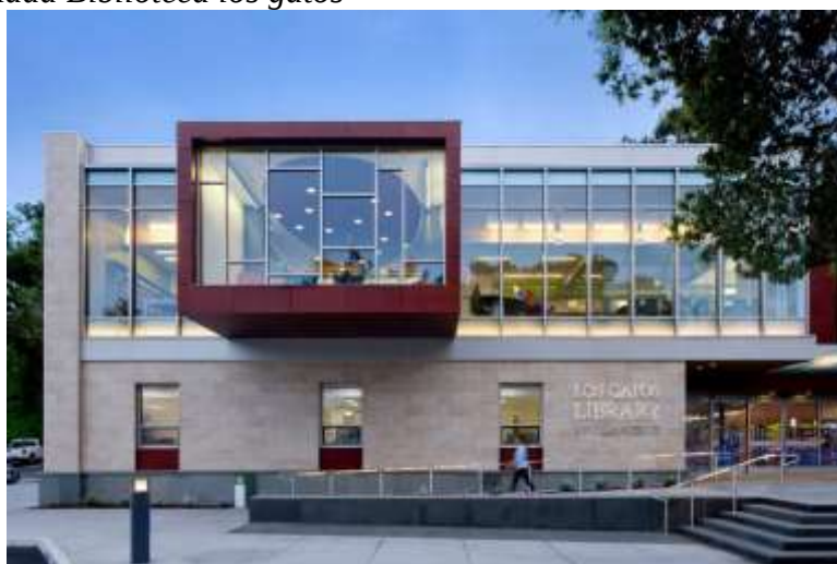
Figura 25. Fachada Biblioteca los gatos
