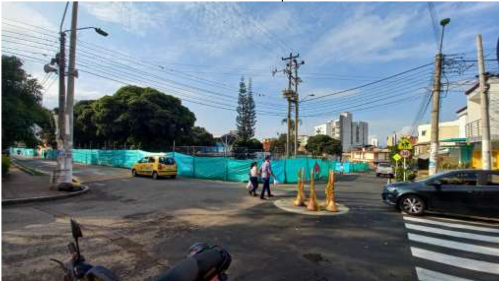
Figura 43. Vista de la Calle 33 con Carrera 38 Esquina
