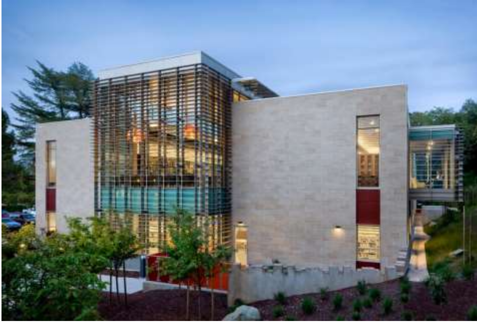
Figura 27. Fachada Biblioteca los gatos
