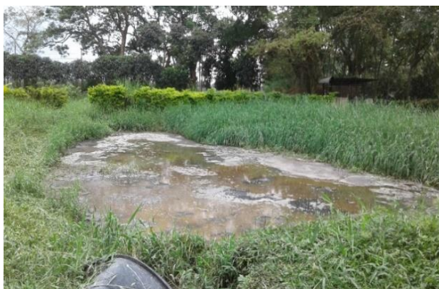
Figura 7. Muestra la laguna 1 (anóxica) del sistema de tratamiento, la cual al momento de la realización de la fotografía se encontraba sin mantenimiento de poda de césped aledaño y extracción de vegetación al interior de la misma. Por: Cortés & Rodríguez, 2017.
