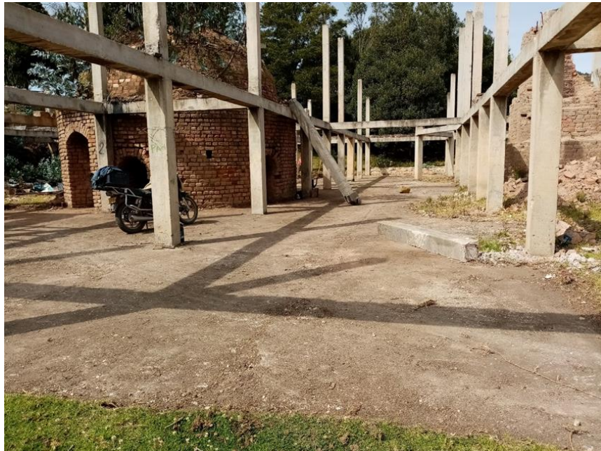
Estructura de antiguo chircal
