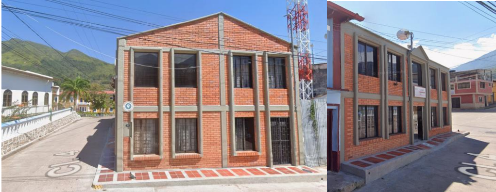
Figura 9.1. Edificio de Mejoras Publicas
