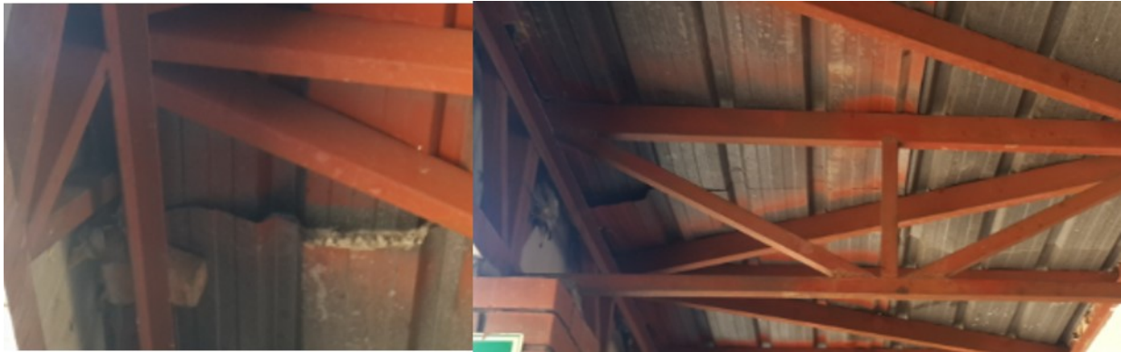
Figura 13: Vista inferior de losa steel deck. Fuente: Propia
