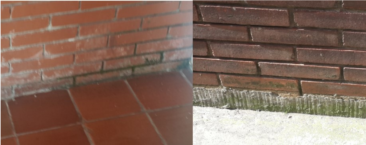
Figura 8: Humedades por capilaridad. Fuente: Propia
