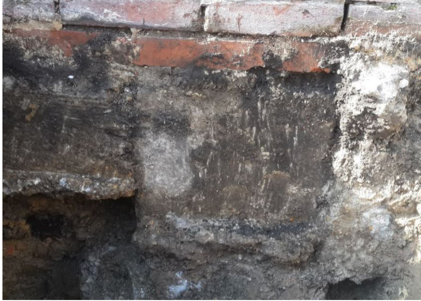
Figura 27: Cimentación de la edificación. Fuente: Propia
