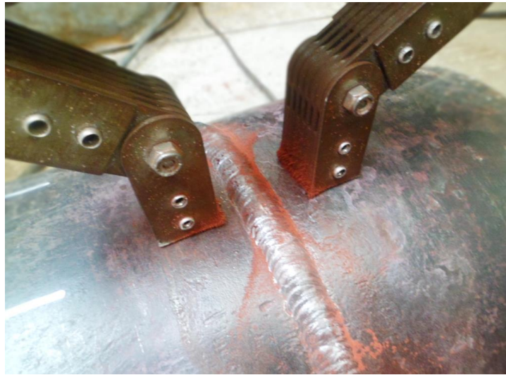
Ilustración 39: Ubicación del Yugo en la presentación del cordón de soldadura.
