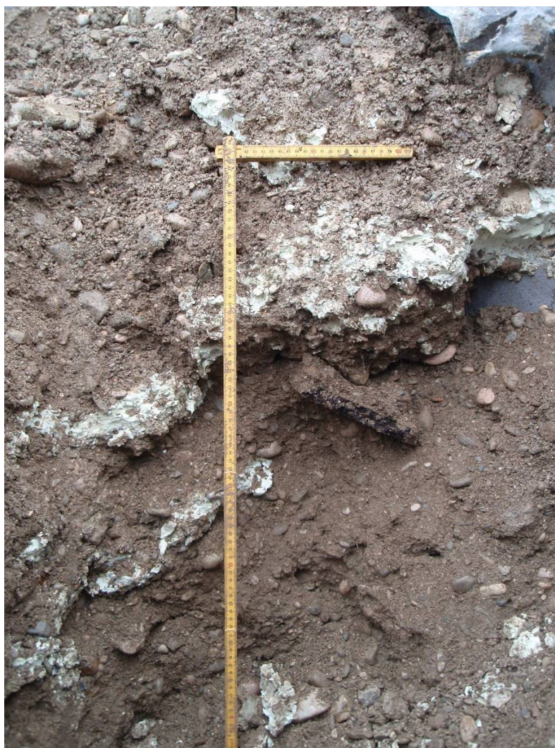
Figura 9, expansión de la resina en la grava
