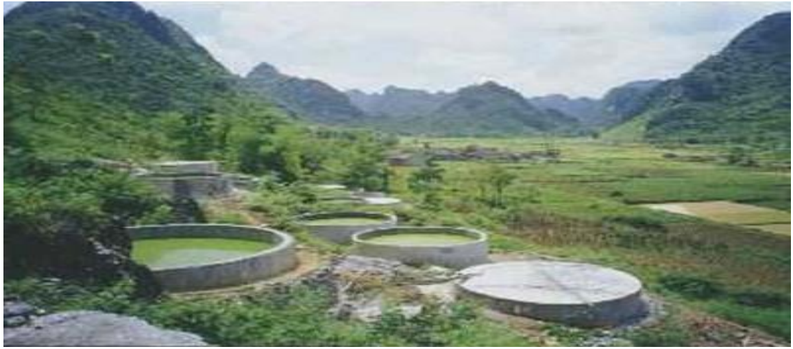
Figura 8: Sistema de recolección agua lluvias en meseta de Loess de Gansu, China.
