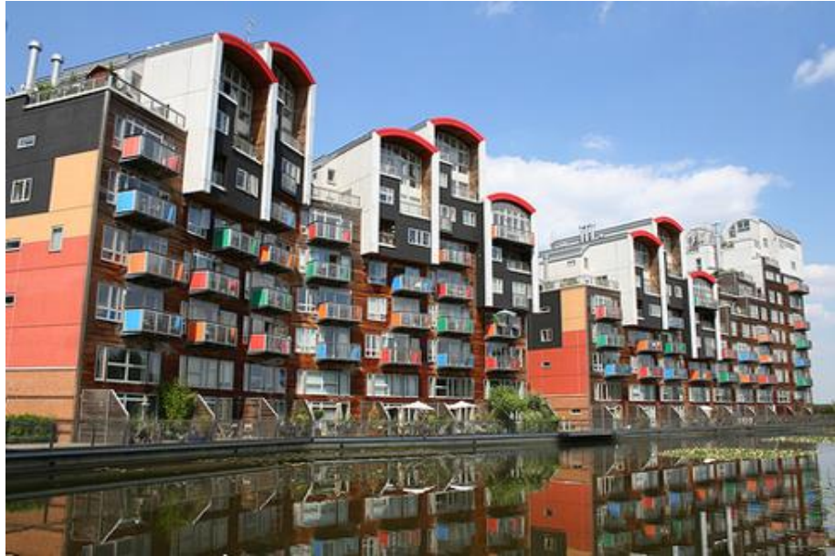
Figura 16: Edificio de apartamentos en Reino Unido con sistemas de captación de lluvias.
