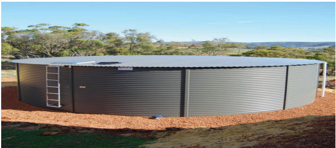
Figura 26: Tanque circular de Almacenamiento en zona rural de Australia
