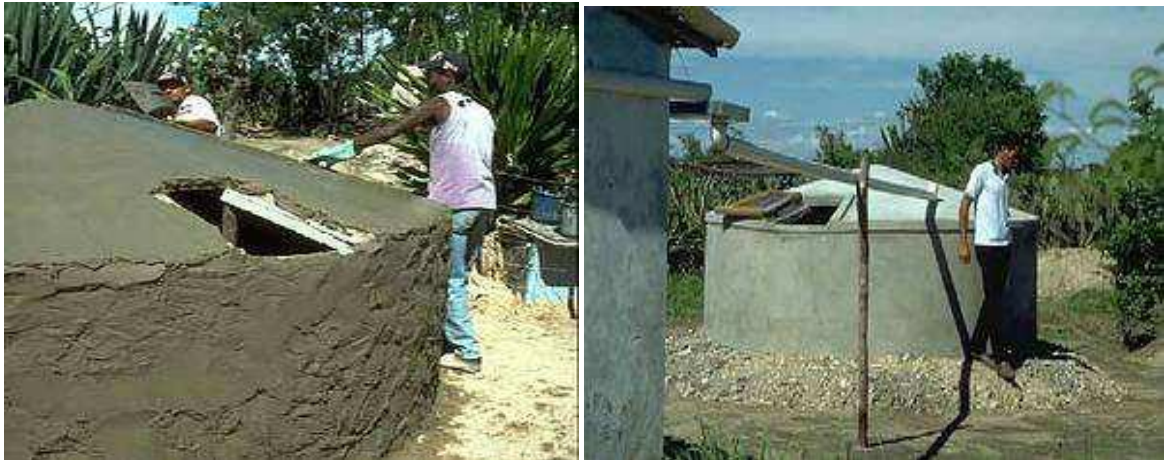
Figura 18: Cisternas rurales de ferrocemento en Sergipe Brasil
