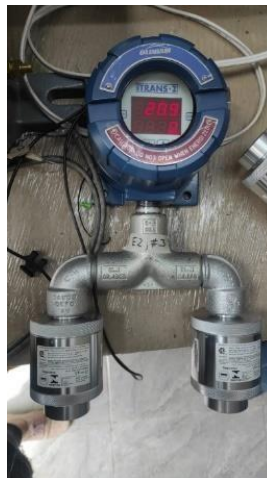
Figura 8. Detector de gas fijo para la medición de dos gases.
