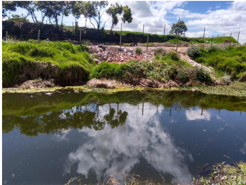
Imagen 17. Zona de disposición de escombros no Autorizada a una orilla del humedal El Resbalón.
