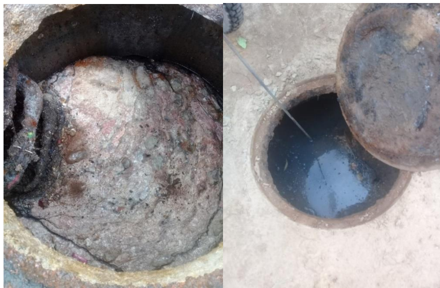
Figura 14. Estado actual de los pozos Fuente: Autor
