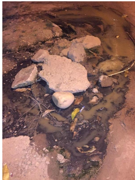
Figura 33. Rebose Cámara Fuente: Autor
