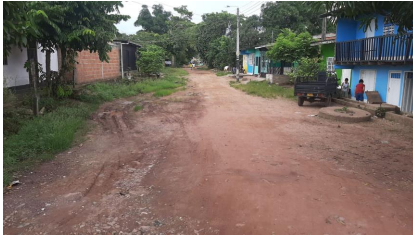
Figura 34. Tramo barrio El Porvenir Fuente: Autor
