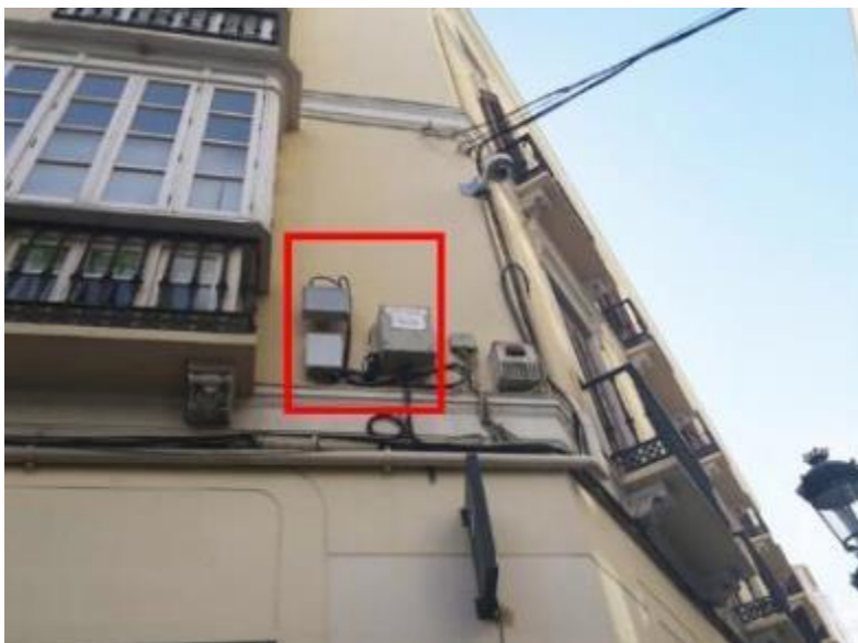
Figura 43. Instalación Small Cell en Fachada
