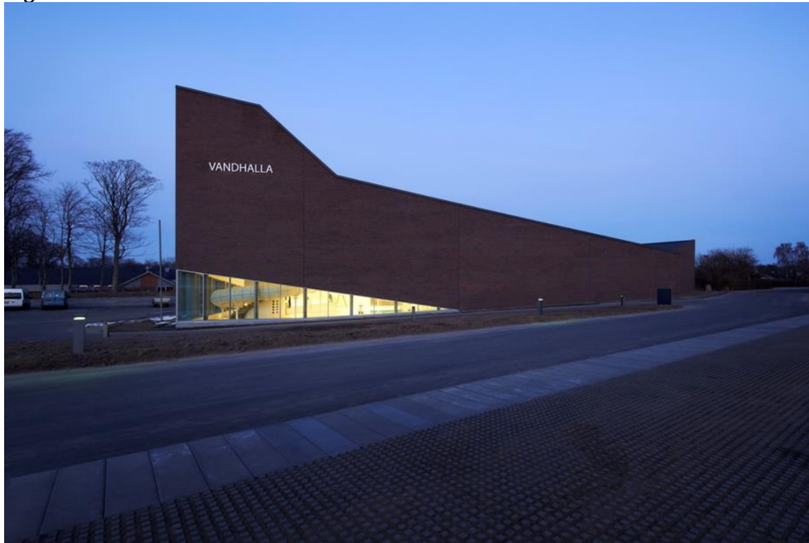
Figura 6. Fachada lateral a la calle del Centro de Rehabilitación Vandhalla.
