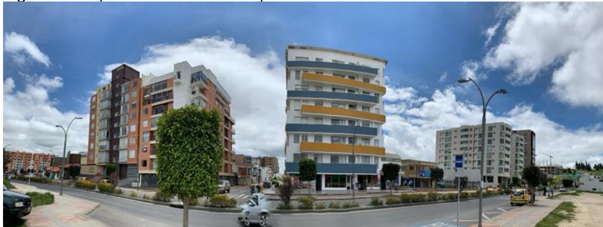
Figura 35. Edificaciones alrededor del predio.
