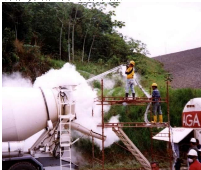
Figura 2. Control de las temperaturas en el concreto.
