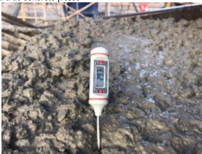
Figura 1. Temperatura de concreto fresco
