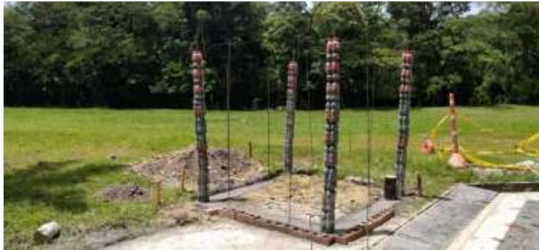
Figura 2: Construcción prototipo botellas PET
