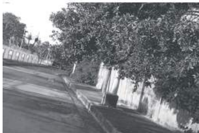
Figura 70- vía actual interior del muelle departamental Fuente: Jay Arias K. 2020
