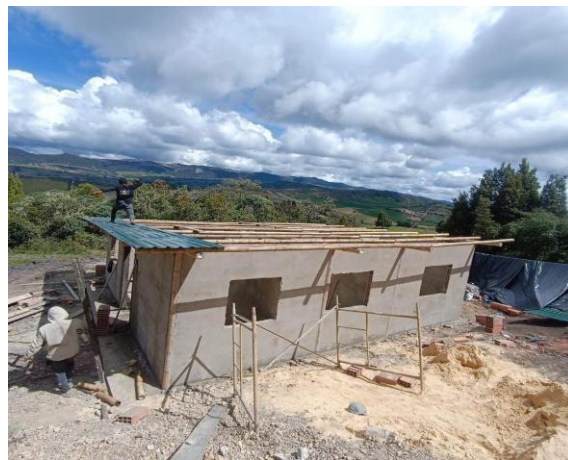
-Imagen 8. Proceso de montaje estructural.
