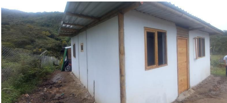
-Imagen 9. Vivienda finalizada y entregada a comunidad rural.
