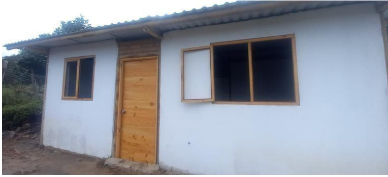
-Imagen 10. Vivienda finalizada y entregada a comunidad rural.
