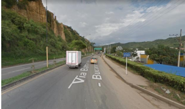
Figura 11. Estado actual vía Bucaramanga-Girón
