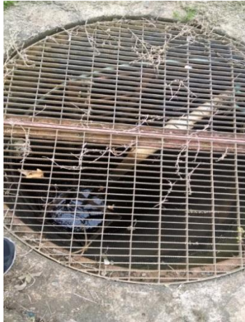
Foto 2. Pozo de cribado de sólidos mayores a 0.5 pulgadas e igualación de carga. Fuente: Los autores
