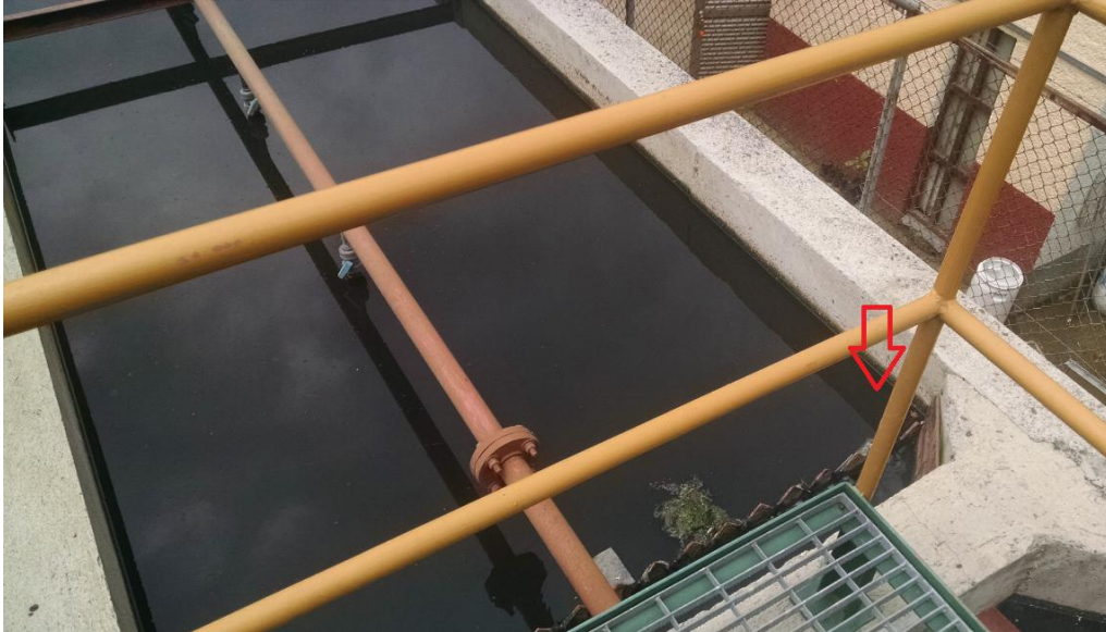
Foto 11. Salida del aireador. Fuente: Los autores
