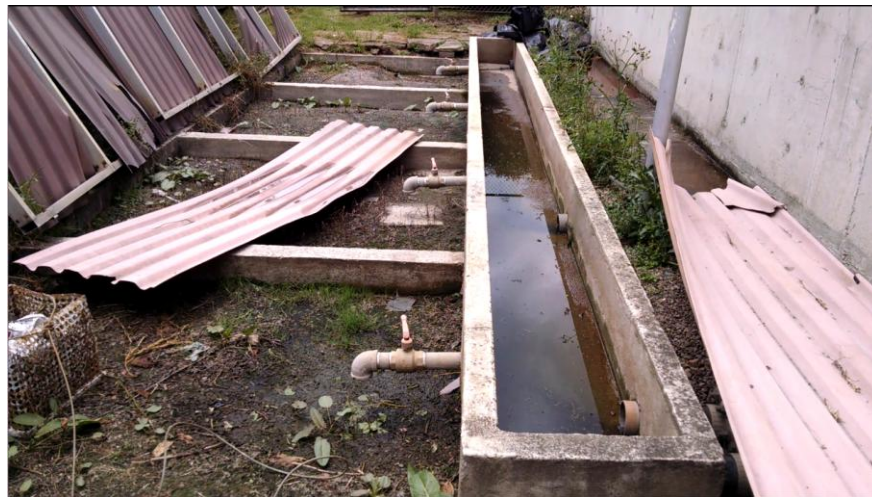
Foto 7. Lecho de secado. Fuente: Los autores
