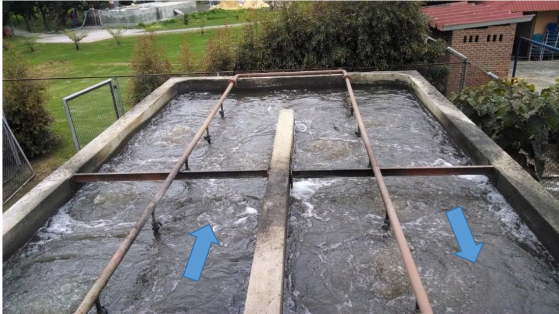
Foto 3. Tanque de aireación salida a la derecha de la foto. Fuente: Los autores
