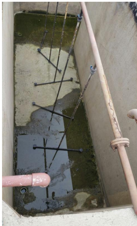
Foto 4. Entrada tanque de aireación. Fuente: Los autores
