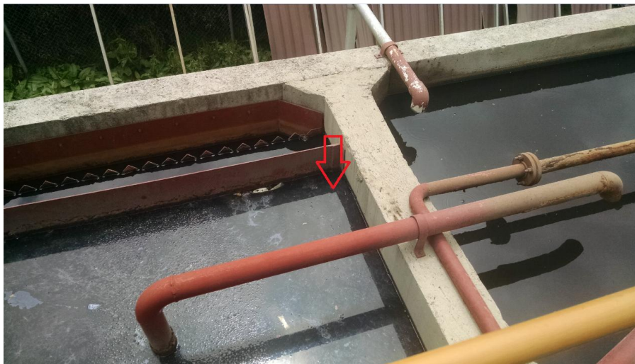
Foto 12. Sedimentador. Fuente: Los autores
