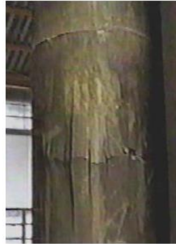
Foto No.6 y 7. Falla por compresión paralela a las fibras (tomado de la referencia No1)
