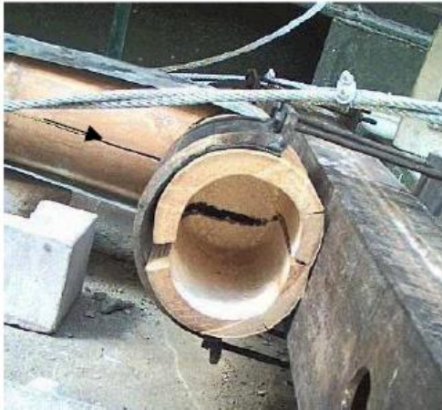
Foto No 8. Falla por compresión perpendicular a las fibras. (tomado de la referencia No3 )
