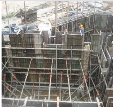
Ilustración 3. Proceso Constructivo -Tanque Reserva- Patinódromo
