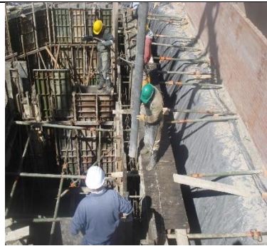
Ilustración 3. Proceso Constructivo -Tanque Reserva- Patinódromo
