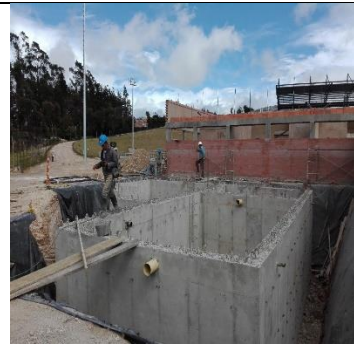
Ilustración 3. Proceso Constructivo -Tanque Reserva- Patinódromo
