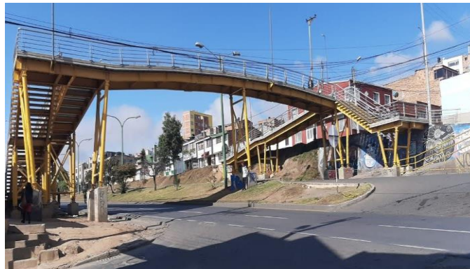
Ilustración 6. Puente peatonal Barrio Jordán vista Norte -Sur
