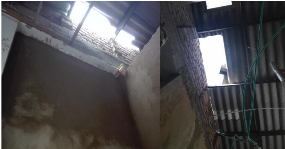
Ilustración 32. Cambio de tejas.
