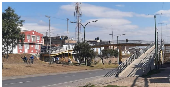
Ilustración 7. Puente peatonal Barrio Jordán vista Sur- Norte
