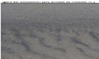
**DESCRIPCIÓN.** Este tipo de daño se presenta con una película o afloramiento del ligante asfáltico sobre la superficie del pavimento generalmente brillante, resbaladiza y usualmente pegajosa.
