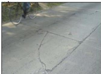
**DESCRIPCIÓN.** Bloque de forma triangular en la losa, se presenta al interceptar las juntas transversales y longitudinales, describiendo un ángulo mayor a 45°, con respecto a la dirección del tránsito.
