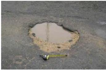
**DESCRIPCIÓN.** Desintegración total de la carpeta asfáltica que deja expuestos los materiales granulares lo cual lleva al aumento del área afectada y el aumento de la profundidad debido a la acción del tránsito.
