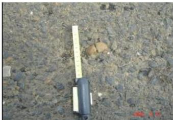
**DESCRIPCIÓN.** Corresponde a la presencia de agregados expuestos fuera del mortero arena-asfalto que puede llegar a aumentar la rugosidad del pavimento, provocando ruido excesivo para el conductor.
