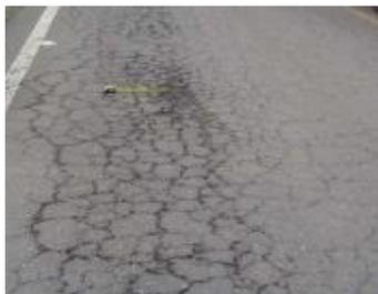
**DESCRIPCIÓN.** Fisuras intercaladas con patrones irregulares. Tiende a iniciarse en el fondo de las capas asfálticas y se propagan a la superficie como fisuras longitudinales paralelas. Este daño tiene por lo general un diámetro menor a 30 cm.
