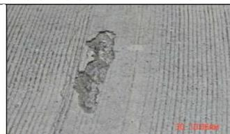
**DESCRIPCIÓN.** Rotura de la superficie de la losa hasta una profundidad del orden de 5 a 15mm, por desprendimiento de pequeños trozos de concreto.
