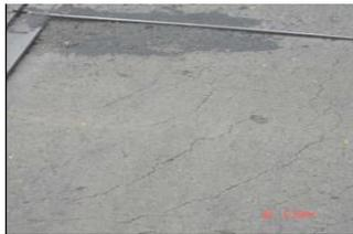
**DESCRIPCIÓN.** Fisuras delgadas, que afectan únicamente la superficie de la losa. La mayoría de las veces adquieren la tendencia de ser paralelas entre sí.
