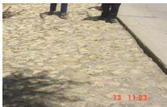
**DESCRIPCIÓN.** Incremento en la abertura de la junta longitudinal entra la berma y el pavimento.
