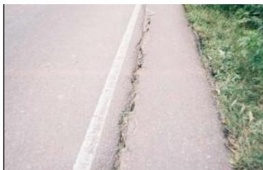
**DESCRIPCIÓN.** Indica el incremento en la separación de la junta existente entre la calzada y la berma.
