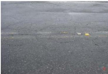
**DESCRIPCIÓN.** La superficie de asfalto se divide en bloques rectangulares, con lados promedios mayores a 0.30 m<sup>3</sup>
