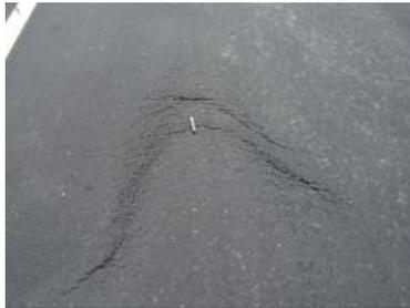
**DESCRIPCIÓN.** Corresponden a fisuras en forma de semicírculo o medialuna, con curvaturas definidas de acuerdo con la fuerza de tracción que produce la llanta sobre el pavimento (al acelerar o frenar). Usualmente aparecen en zonas montañosas, en curvas o intersecciones.
