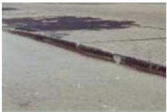
**DESCRIPCIÓN.** Falla provocada por el tránsito que corresponde a un desnivel de la losa en su junta con respecto a una losa vecina.
