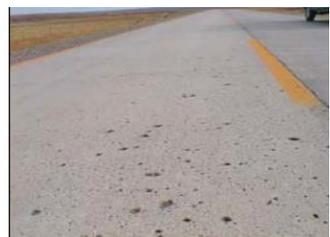
**DESCRIPCIÓN.** Consiste en pérdida constante de agregado grueso de la superficie, debido a la progresiva desintegración de la superficie del pavimento por pérdida de material fino desprendiendo de matriz arena-cemento del concreto, provocando una superficie con pequeñas cavidades.
