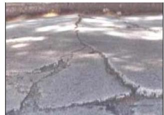
**DESCRIPCIÓN.** Sobre elevación abrupta de la superficie del pavimento, localizada generalmente en zonas contiguas a una junta o una grieta, habitualmente el concreto afectado se quiebra en varios trozos.
