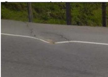
**DESCRIPCIÓN.** Los hundimientos corresponden a depresiones localizadas en el pavimento con respecto al nivel de la rasante. Los hundimientos pueden estar orientados de forma longitudinal o transversal al eje de la vía o forma de medialuna.
