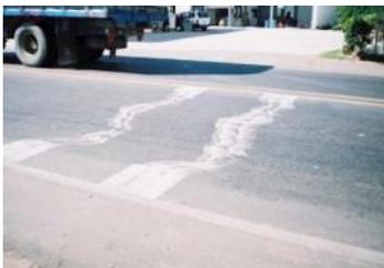
**DESCRIPCIÓN.** Depresión de la zona localizada sobre la trayectoria de las llantas de los vehículos. Con frecuencia se encuentra acompañado de una elevación de las áreas adyacentes a la zona deprimida y de fisuración.
