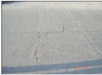
**DESCRIPCIÓN.** Grietas que se presentan perpendiculares al eje de circulación de la vía. Pueden extenderse desde la junta transversal hasta la longitudinal.
