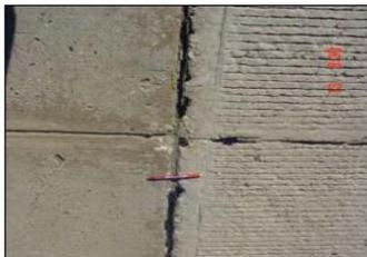
**DESCRIPCIÓN.** Desprendimiento o rompimiento del sello de las juntas longitudinales o transversales, que permite la entrada de materiales incomprensibles e infiltración de agua superficial.
