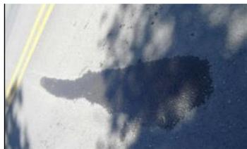
**DESCRIPCIÓN.** Presencia del líquido en la superficie del pavimento en instantes en los cuales no hay lluvia.
