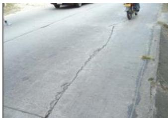
**DESCRIPCIÓN.** Grietas predominantemente paralelas al eje de la calzada o que se extienden desde una junta transversal hasta el borde la losa.
