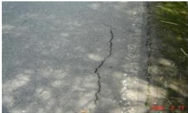
**DESCRIPCIÓN.** Fisuras con tendencia longitudinal a semicircular localizadas cerca del borde de la calzada.
