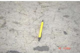
**DESCRIPCIÓN.** Fisuras limitadas sólo a la superficie del pavimento. Frecuentemente las grietas de mayores dimensiones se orientan en sentido longitudinal.
