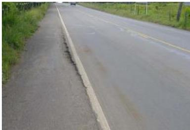
**DESCRIPCIÓN.** Diferencia de elevación entre la calzada y la berma, debido a un deslizamiento de la berma. Permite la infiltración de agua hacia el interior de la estructura del pavimento, provocando su deterioro.
