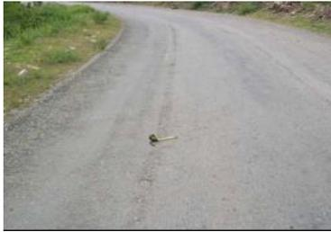
**DESCRIPCIÓN.** Corresponde a franjas o canales longitudinales donde se han perdido los agregados de la mezcla asfáltica.
