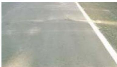
**DESCRIPCIÓN.** Corresponde a la salida de agua infiltrada, junto con materiales finos de la capa de base por las grietas, cuando circulan sobre ellas las cargas de tránsito.
