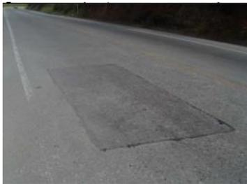
**DESCRIPCIÓN.** Los parches corresponden a áreas donde el pavimento original fue removido y reemplazado por una materia similar o diferente, ya sea para reparar la estructura o para permitir la instalación o reparación de alguna red de servicios.
