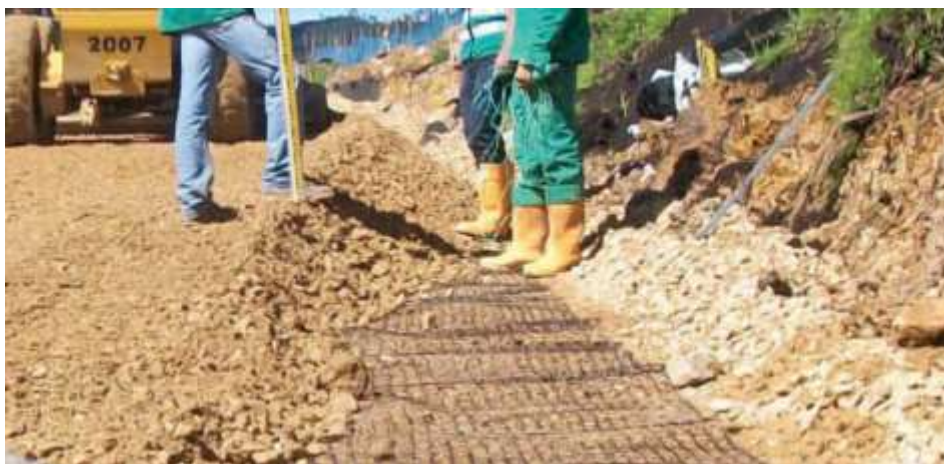
Figura 6,13. Vía reforzada con geomalla (Pavco, 2012)
