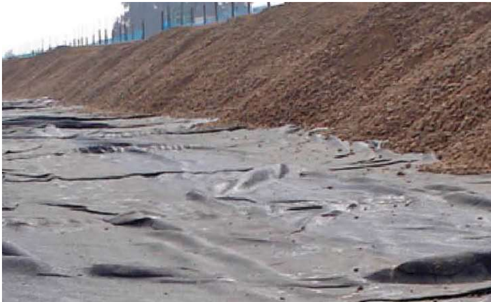
Figura 6,12. Geomembrana instalada en obra vial (Pavco, 2012)
