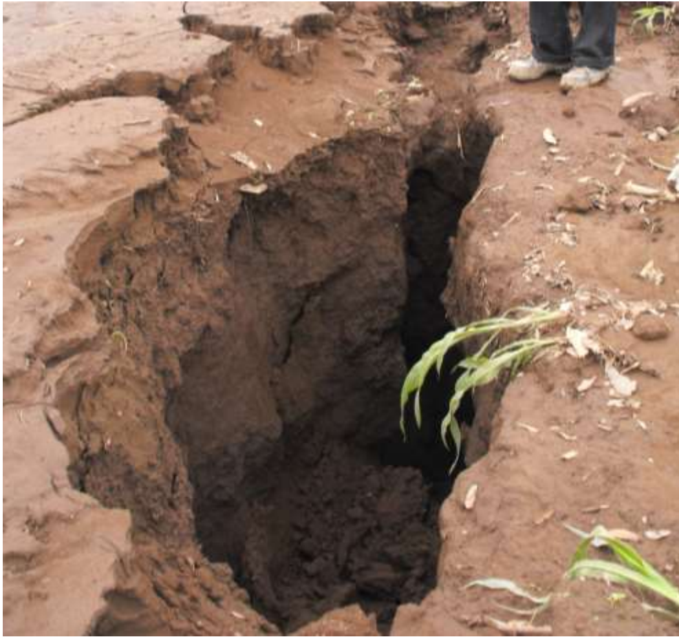
Figura 2,25. Fisuras por pérdida de humedad por extracción mediante pozos en ciudad de México (Hernández, 2011).
