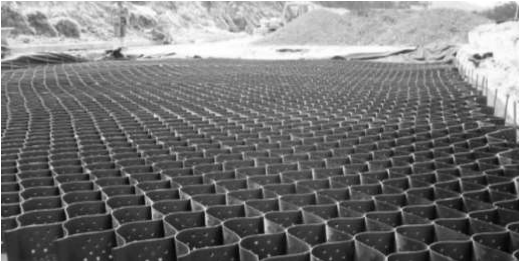
Figura 6,14. Geoceldas para reforzamiento de vías (Pavco, 2012)
