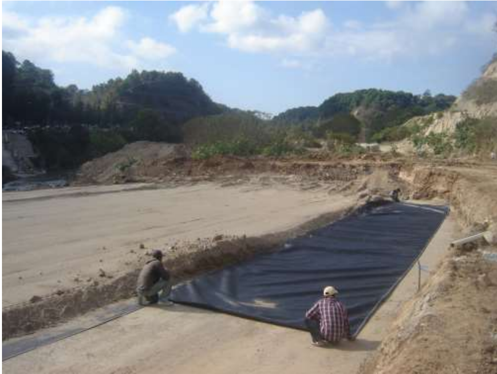
Figura 6,11. Instalación de Geotextil en zona vial (Martínez, 2012)
