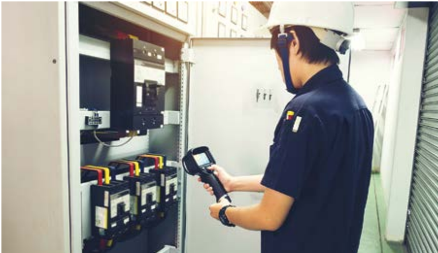
Figura 24. Cámara termográfica - Medición de temperatura.
